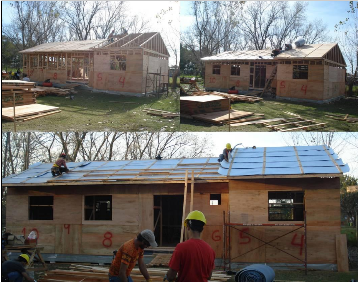
Foto 14: Superior Izquierda: Colocación de tableros fenólicos en techo; Superior Derecha e Inferior: Colocación de membrana aislante, bulines y clavaderas. Fuente: propia y Jorge Nedela.
