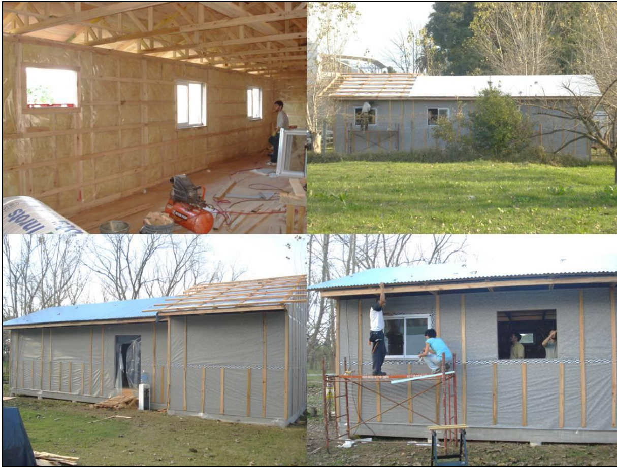
Foto 19: Colocación de aislamiento interior-techado-colocación de aberturas
