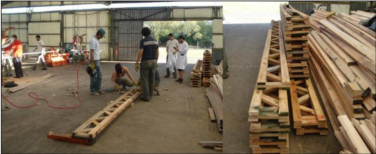
Foto 2: corte y armado de piezas partes: vigas reticuladas. Fuente: propia.
