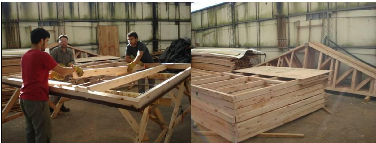
Foto 3: corte y armado de piezas partes: paneles de muro. Fuente: propia.
