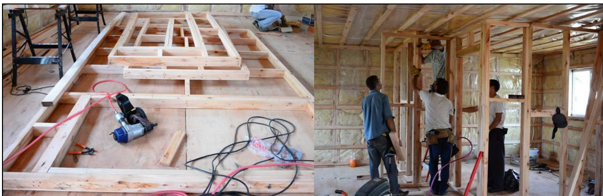
Foto 22: armado y colocación de tabiques internos. Fuente: propia y Jorge Nedela.
