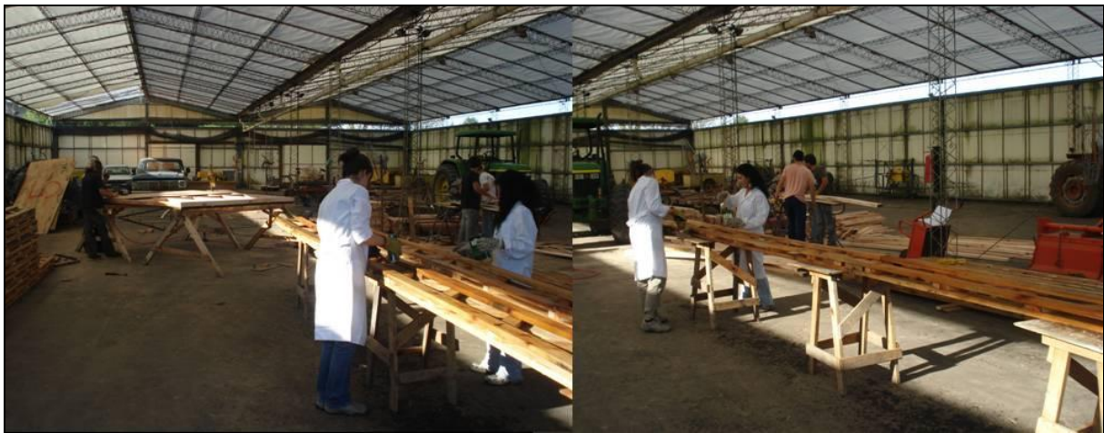
Foto 5: aplicación de producto preservante en vigas reticuladas de madera. Fuente: propia.
