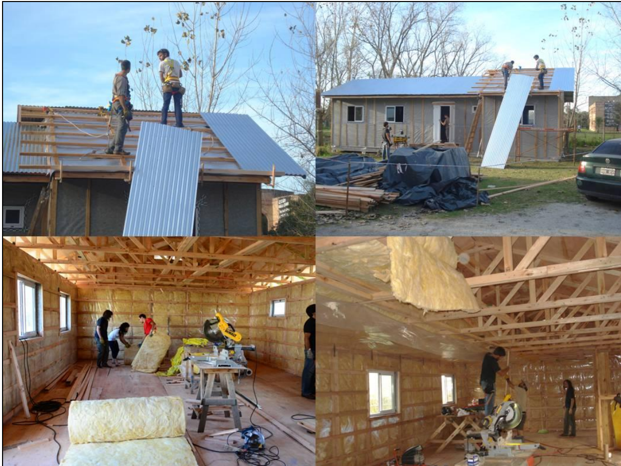
Foto 20: Superior: Techado-Colocación de puerta de aluminio; Inferior: Colocación de aislamiento interior.
