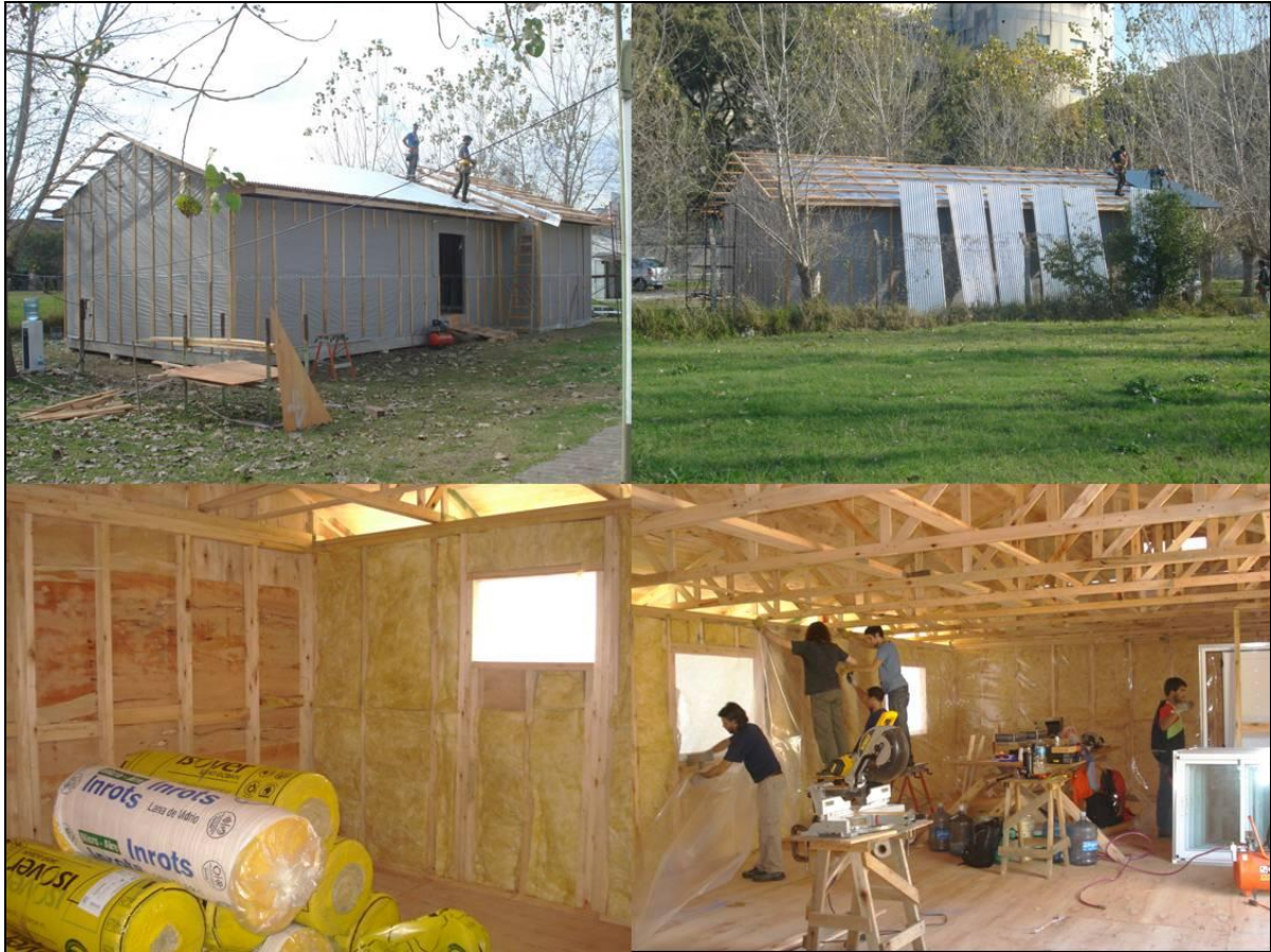
Foto 18: Superior: Techado; Inferior: colocación de aislamiento interior.
