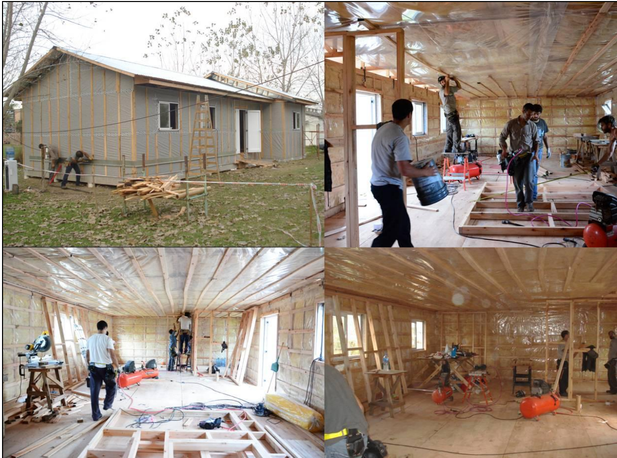
Foto 21: Superior izquierda: colocación babeta de nivelación de zócalo; Superior Derecha: colocación de aislamiento interior de techo y armado de tabiques internos; Inferior: armado y colocación de tabiques internos.
