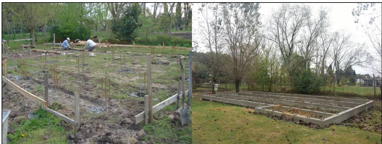
Foto 1: emplazamiento general de las fundaciones-finalización de obra. Fuente: propia.
