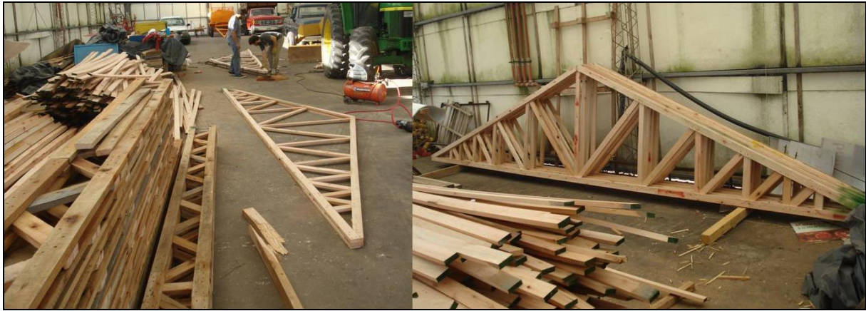
Foto 4: corte y armado de piezas partes: cabriadas. Fuente: propia.
