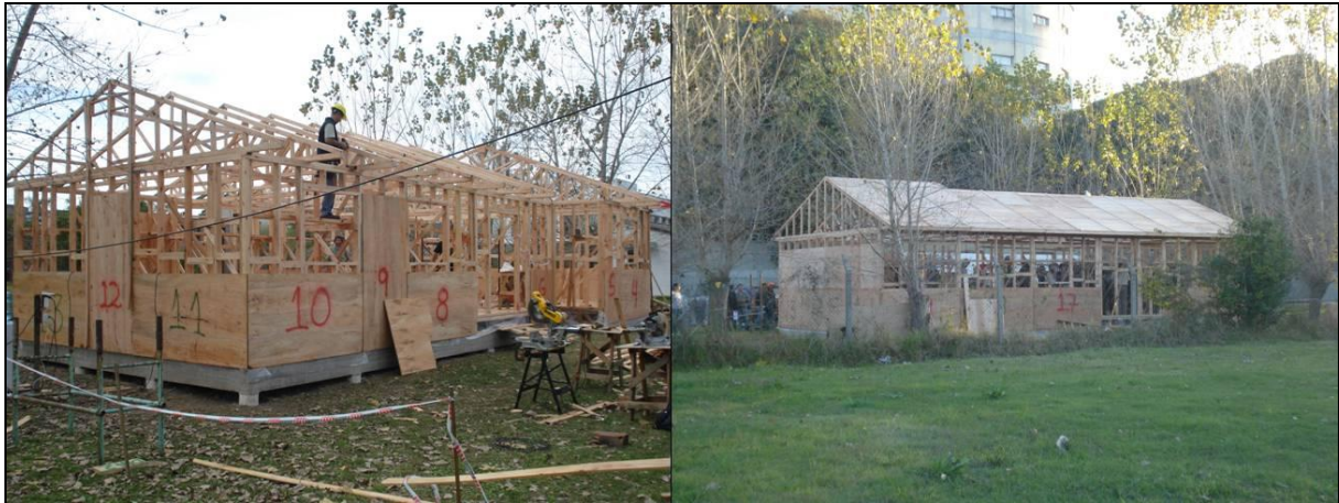
Foto 13: Colocación de cabriadas y tableros fenólicos de techo (10 mm). Finalización del día. Fuente: propia y Jorge Nedela.
