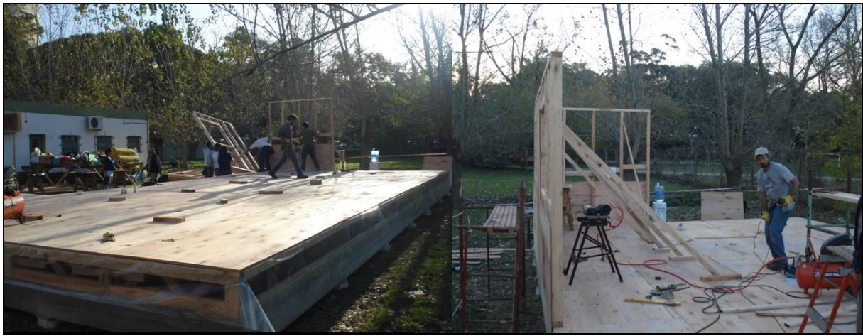
Foto 8: Piso terminado e inicio de colocación de paneles de muro.
