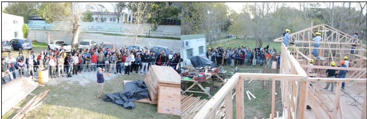
Foto 12: Visita a la construcción-Comienzo de colocación de cabriadas. Fuente: Jorge Nedela.
