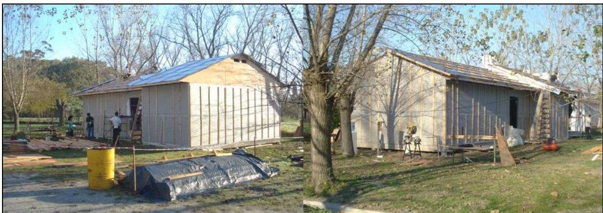
Foto 17: Colocación de chapas-Aislamiento exterior con membrana gas permeable.
