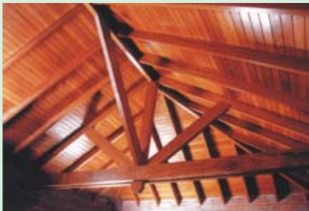
Estructura de techo
