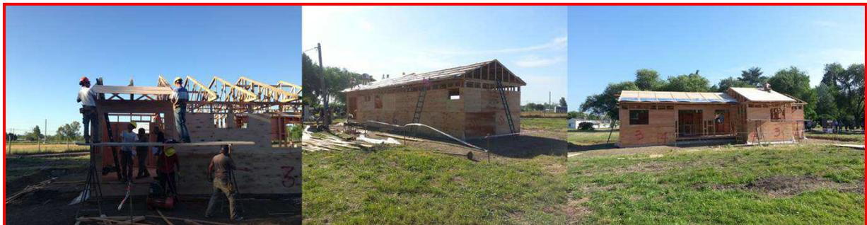
Foto 23: Colocación de paneles de techo, clavaderas y fieltro ultraliviano.
