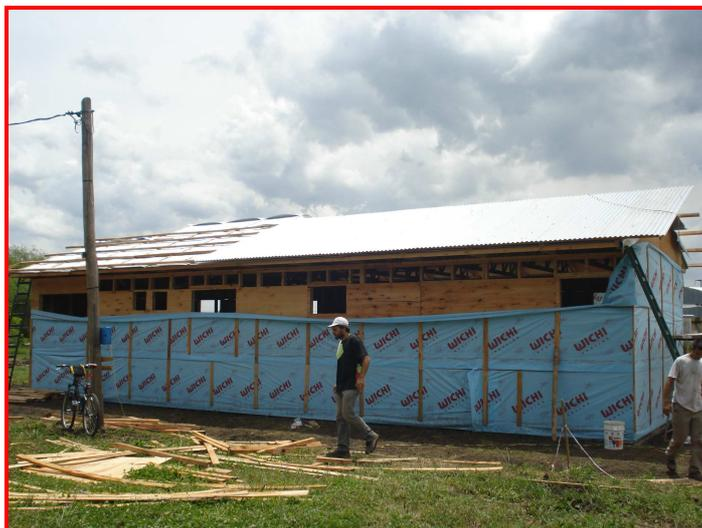
Foto 26: Colocación de membrana gas permeable y chapas.
