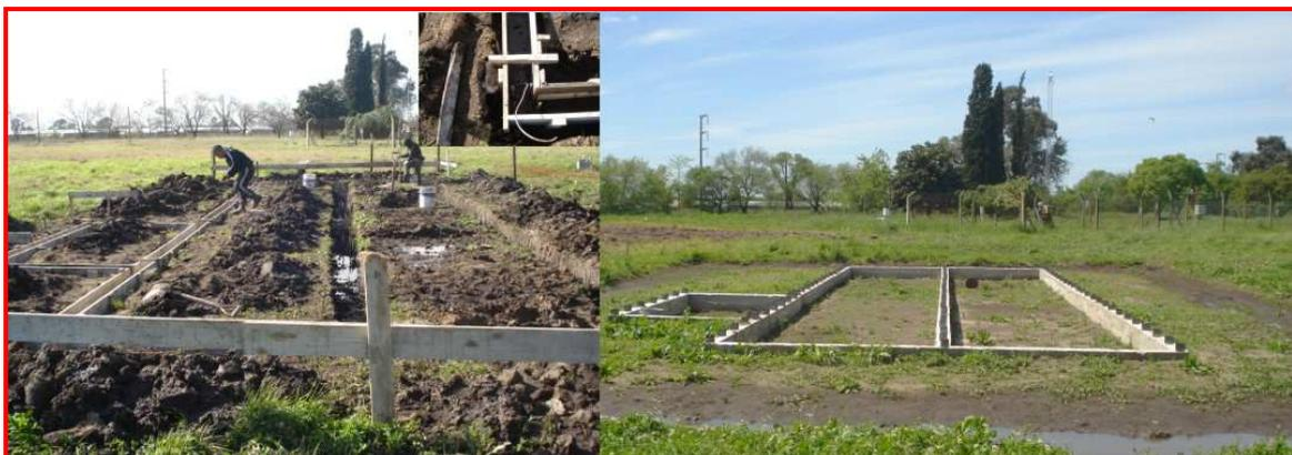
Foto 7: emplazamiento general de las fundaciones-detalle de las vigas de fundación-finalización de obra.
