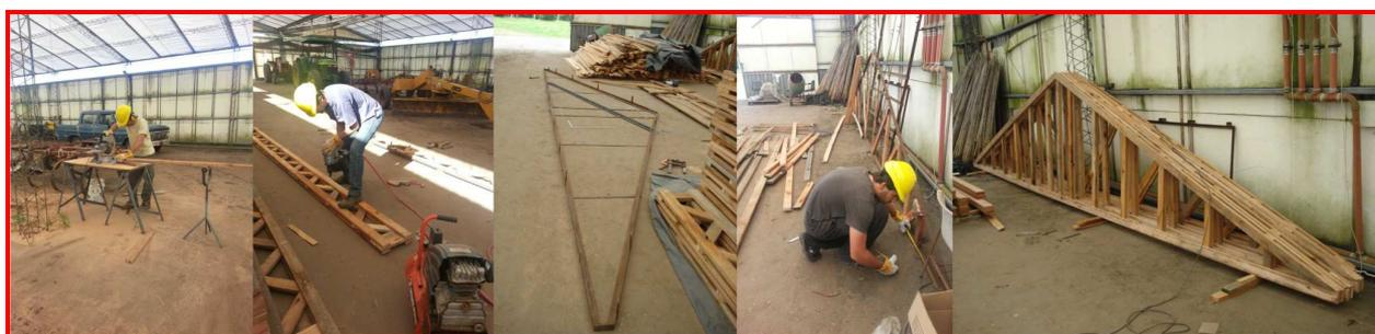
Foto 5: corte y armado de piezas partes: vigas de fundación y cabriadas.
