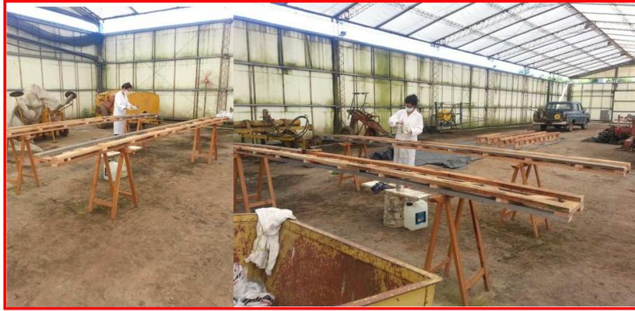
Foto 6: aplicación de producto ignífugo en vigas de fundación.
