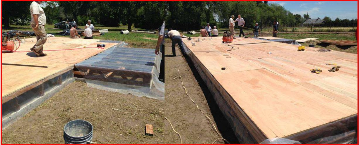
Foto 12: Vigas de fundación de madera cubierta de nylon 200 micrones (superior)-paneles fenólicos de piso (18mm).
