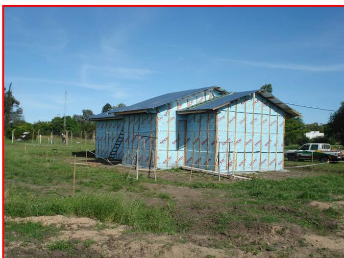
Foto 27: Finalización de colocación de membrana gas permeable y chapas
