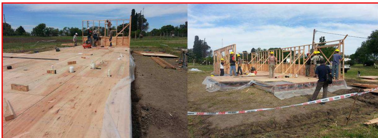
Foto 16: Colocación de paneles de muro.
